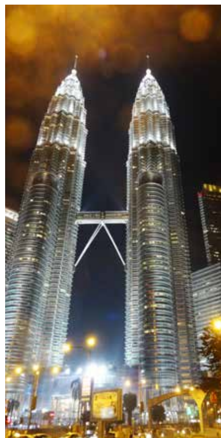
Die Petronas Towers in Kuala Lumpur überragen mit ihren 452 Metern Höhe die malaysische Millionenmetropole. Sechs Jahre dauerte der Bau der Zwillingstürme, gemeinsam gelten sie heute als achthöchstes Gebäude der Welt.
