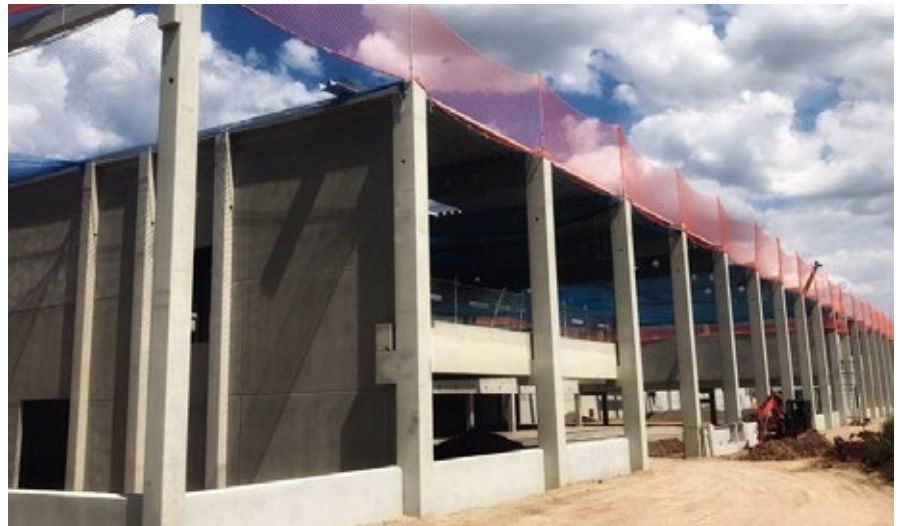
Panem baut seine zweite Werkshalle in Bleicherode, Bild: Panem Backstube GmbH/Doreen Thon
