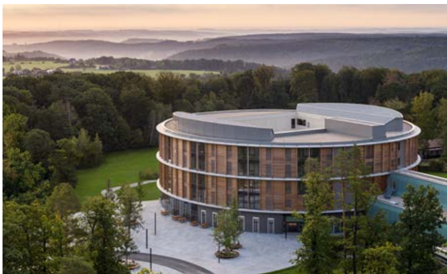
Das vom berühmten Architekten Matteo Thun gestaltete Bettenhaus in Eisenberg. Bild: HGEsch
